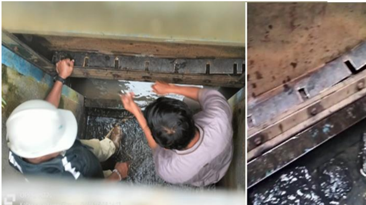
Gambar 3: Pemasangan penyumbat atau sealing
